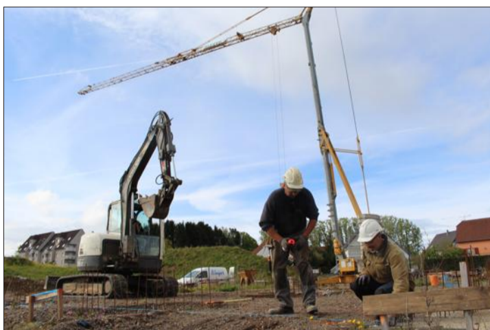
Le bâtiment d'accueil (200 m 2 ), encore en cours de construction, sera le « centre névralgique » du futur village senior.
